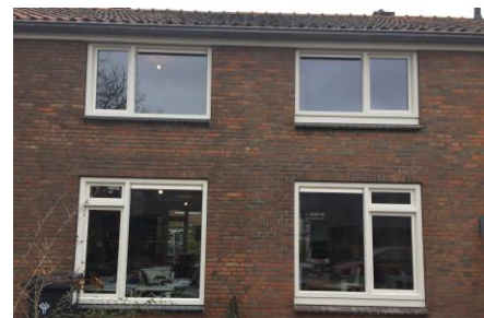
Links de kozijnen van de proefwoning, rechts de nieuwe oplossing.
