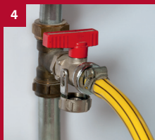
4 Vulslang aansluiten op de vul-/aftapkraan.
