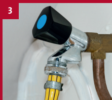
3 Vulslang aansluiten op de tapwaterkraan.
