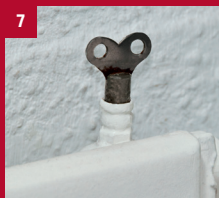
7 Ontluchtingskraantjes een voor een openen en sluiten.
